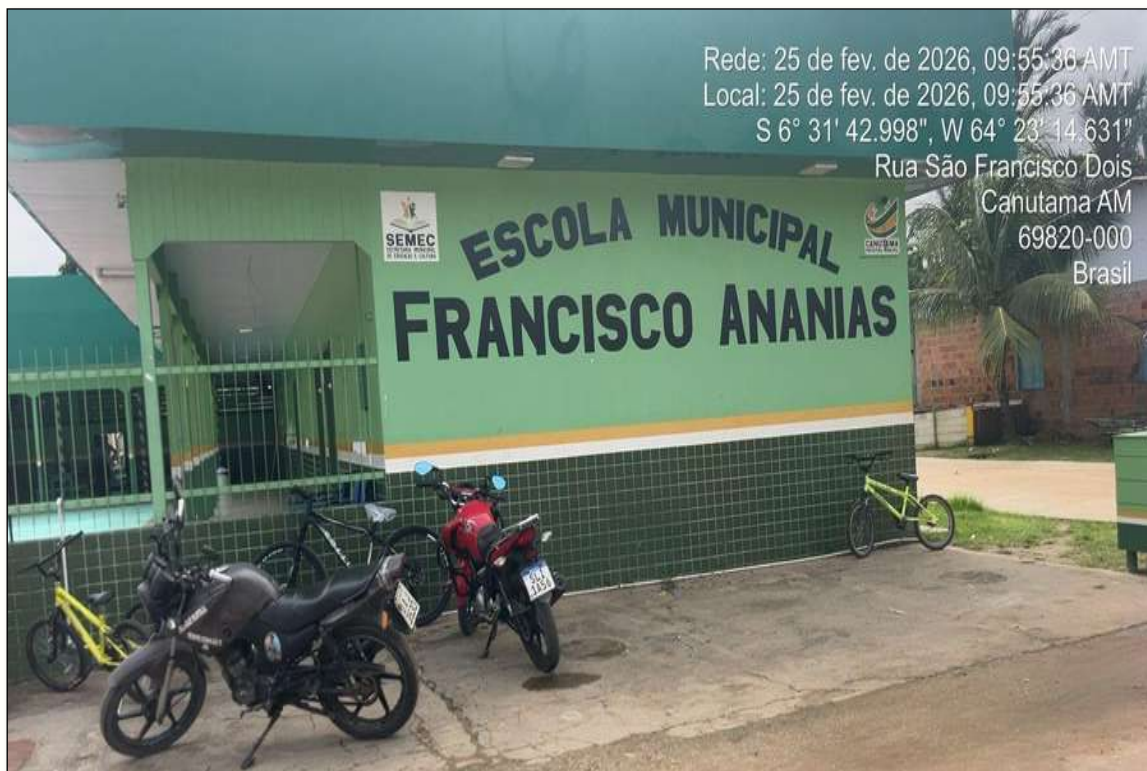
Figura 62 - Escola municipal de Canutama/AM. Fonte: Registro de campo (2026).
