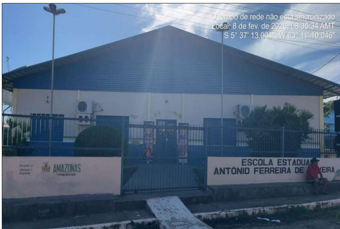
Figura 39 - Escola Estadual de Tapauá/AM. Fonte: Registro de campo (2026).
