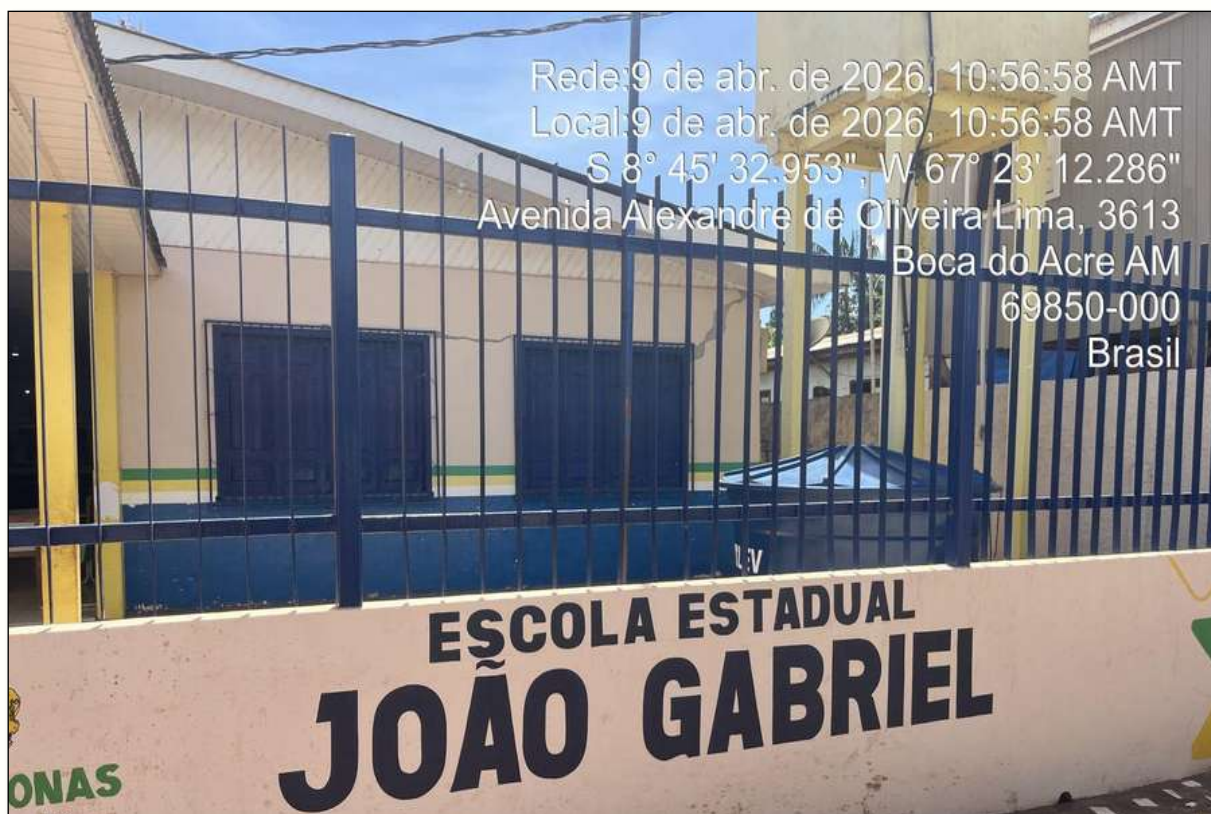
Figura 108 - Escola estadual de Boca do Acre/AM. Fonte: Registro de campo (2026).
