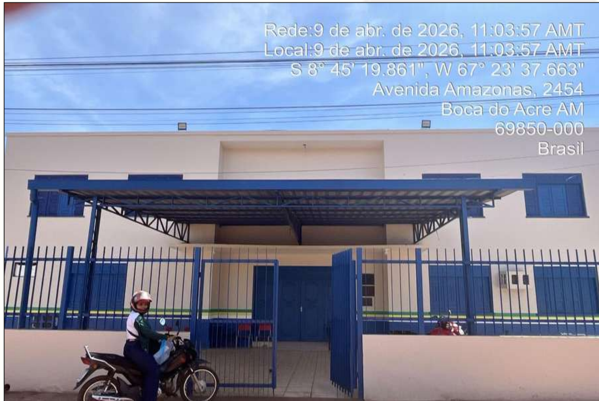
Figura 111 - Escola estadual de Boca do Acre/AM. Fonte: Registro de campo (2026).
