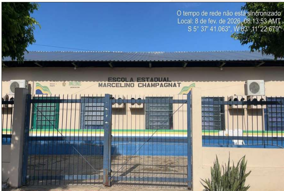
Figura 40 - Escola Estadual de Tapauá/AM. Fonte: Registro de campo (2026).
