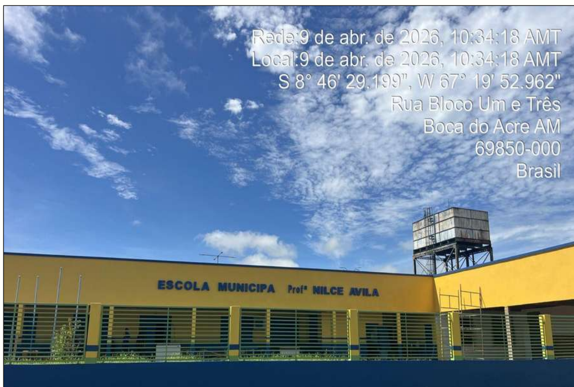
Figura 102 - Escola municipal de Boca do Acre/AM. Fonte: Registro de campo (2026).
