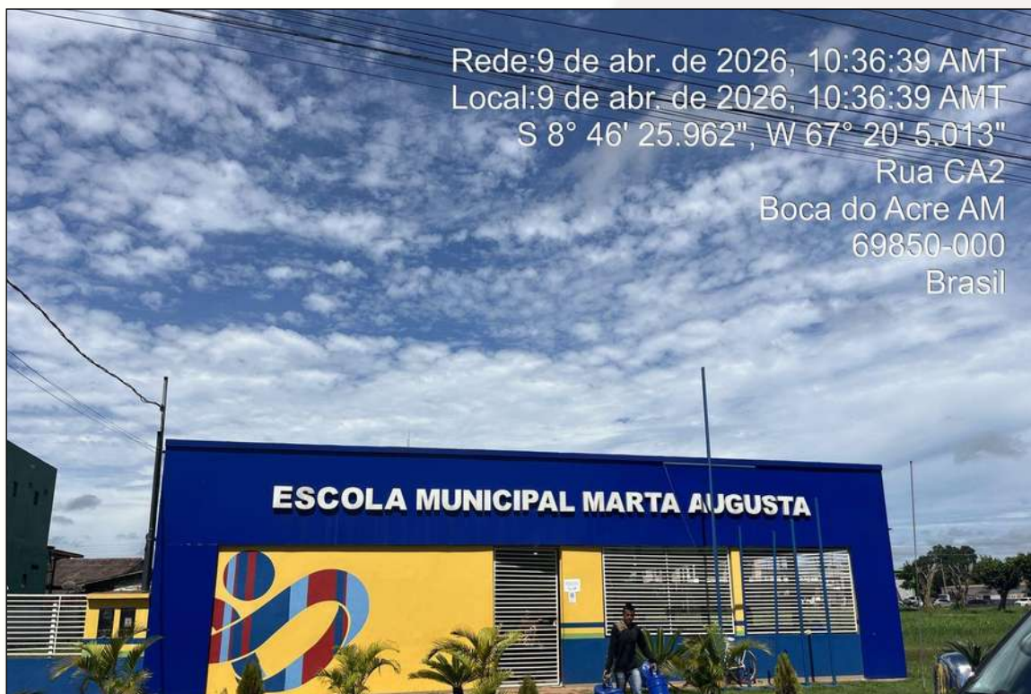
Figura 103 - Escola municipal de Boca do Acre/AM. Fonte: Registro de campo (2026).
