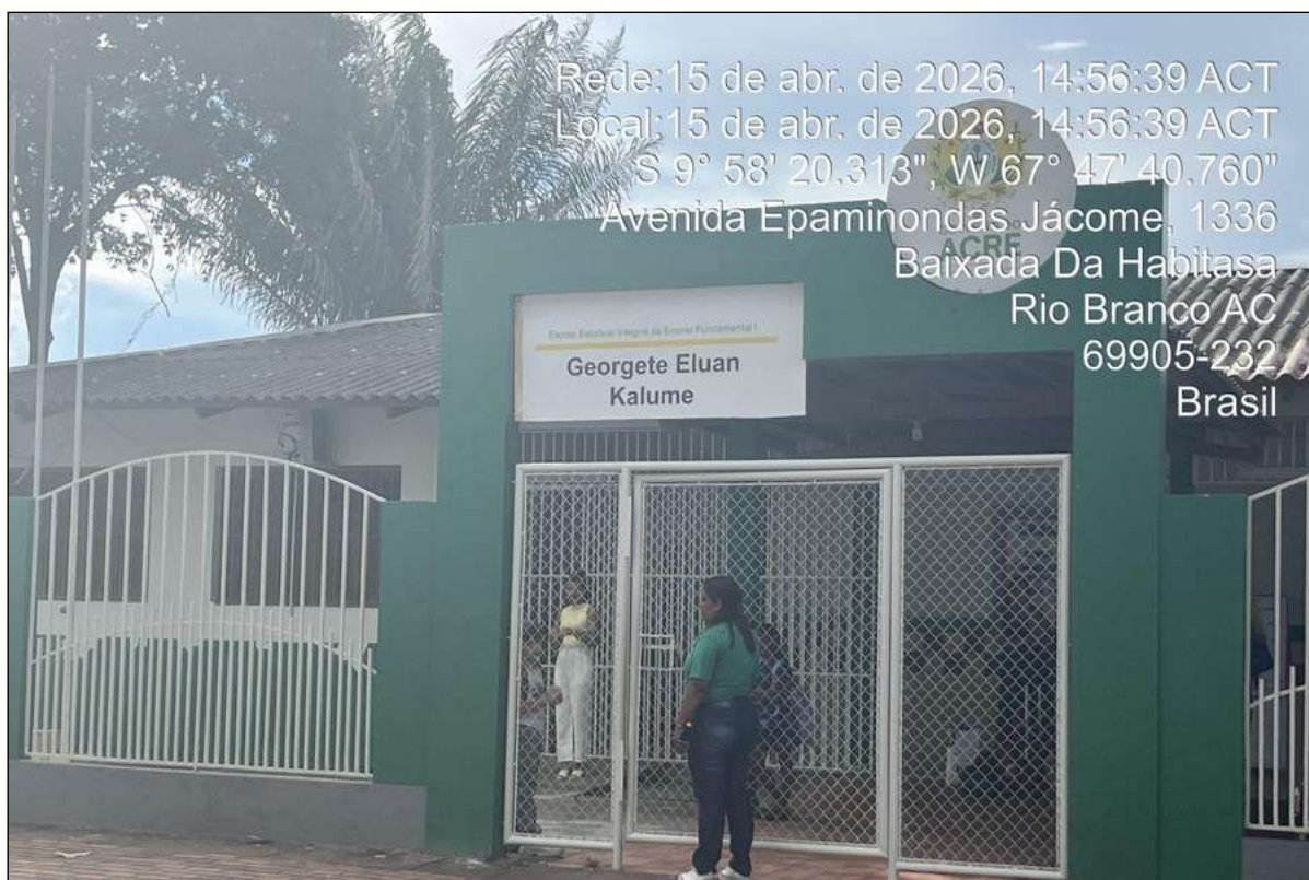
Figura 129 - Escola estadual de Rio Branco/AC. Fonte: Registro de campo (2026).
