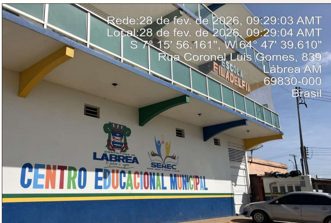
Figura 71 - Escola municipal de Lábrea/AM. Fonte: Registro de campo (2026).
