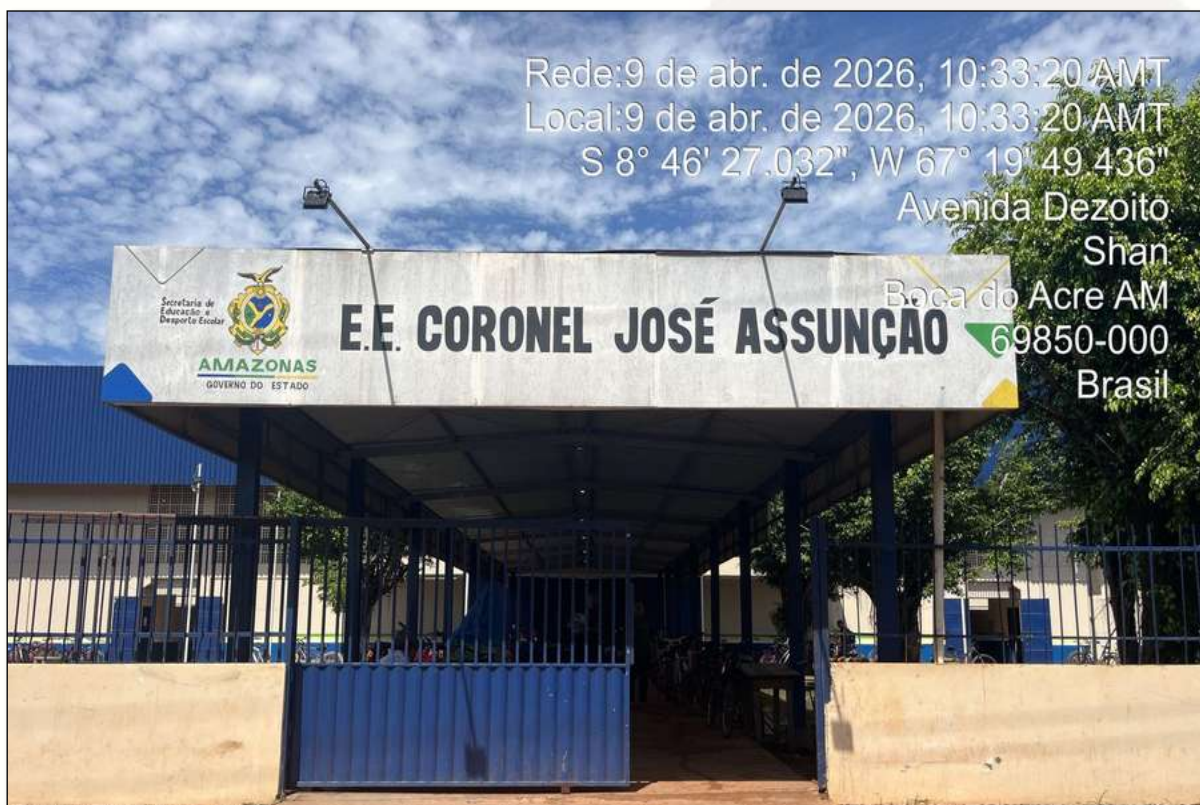
Figura 107 - Escola estadual de Boca do Acre/AM. Fonte: Registro de campo (2026).
