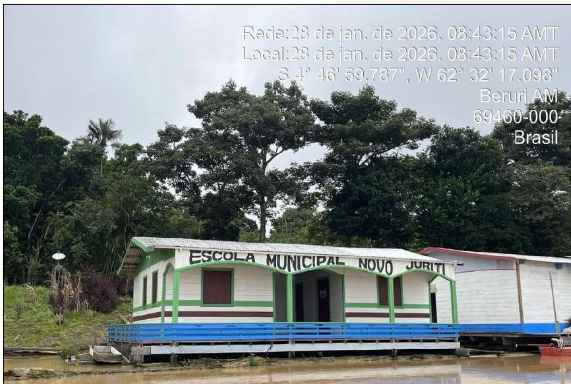
Figura 29 - Escola municipal de Novo Juruti/AM. Fonte: Registro de campo (2026).
