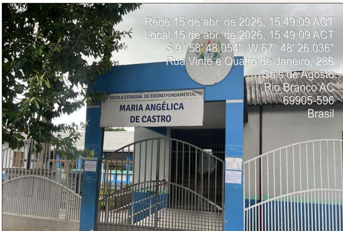
Figura 128 - Escola estadual de Rio Branco/AC. Fonte: Registro de campo (2026).
