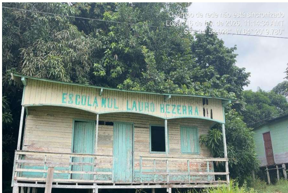
Figura 45 -Escola municipal de Nova Olinda/AM. (Na ocasião desativada).Fonte: Registro de campo (2026).
