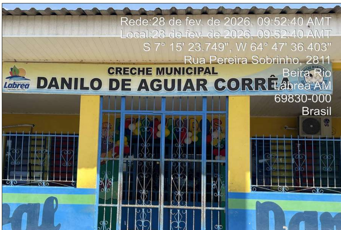
Figura 72 - Escola municipal de Lábrea/AM. Fonte: Registro de campo (2026).
