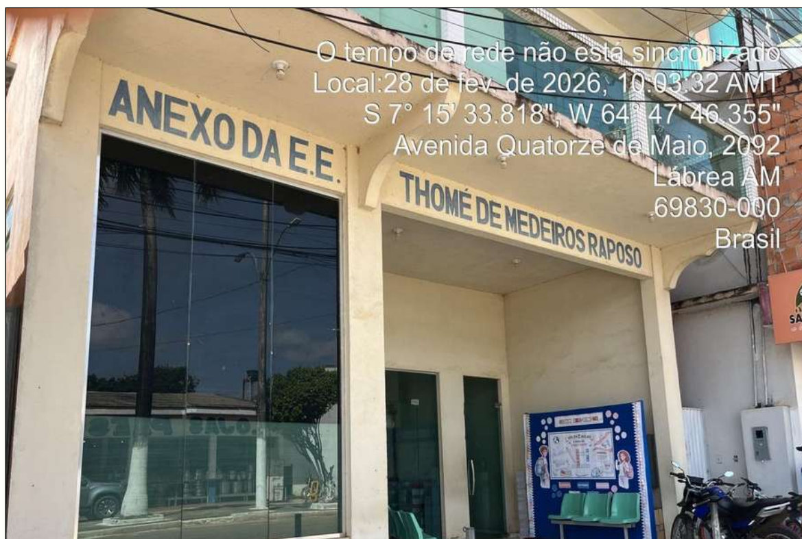
Figura 74 - Escola municipal de Lábrea/AM. Fonte: Registro de campo (2026).
