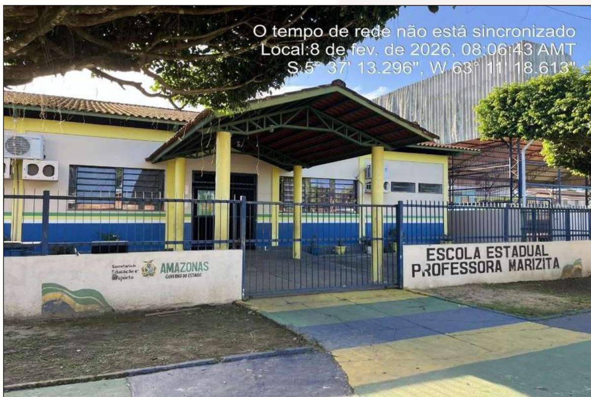
Figura 38 - Escola Estadual de Tapauá/AM. Fonte: Registro de campo (2026).
