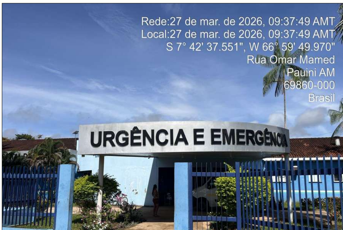
Figura 86 - Hospital municipal de Pauini/AM. Fonte: Registro de campo (2026).
