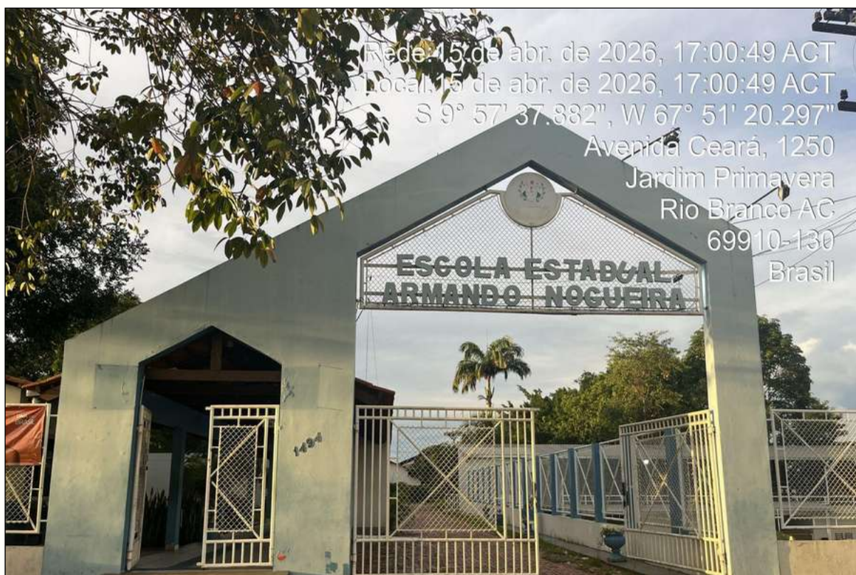
Figura 127 - Escola estadual de Rio Branco/AC. Fonte: Registro de campo (2026).
