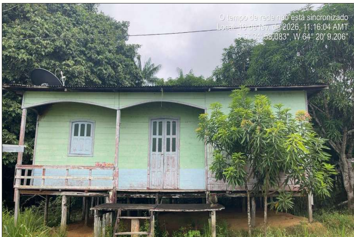
Figura 47 - Local onde está acontecendo as aulas em Nova Olinda-AM. Fonte: Registro de campo (2026).
