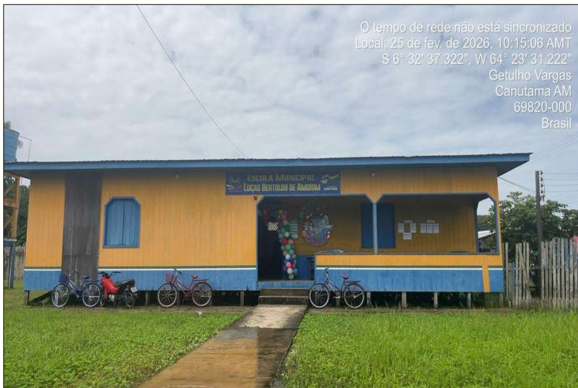
Figura 64 - Escola municipal de Canutama/AM. Fonte: Registro de campo (2026).
