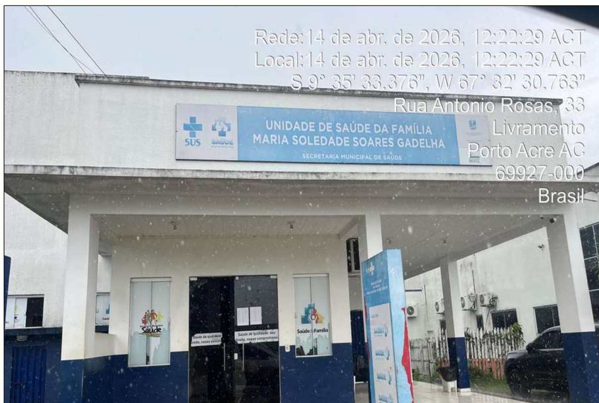
Figura 121 - UBS de Porto Acre/AC. Fonte: Registro de campo (2026).
