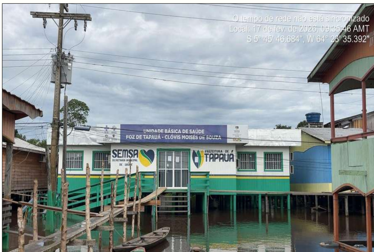
Figura 50 - UBS de Foz de Tapauá/AM. Fonte: Registro de campo (2026).
