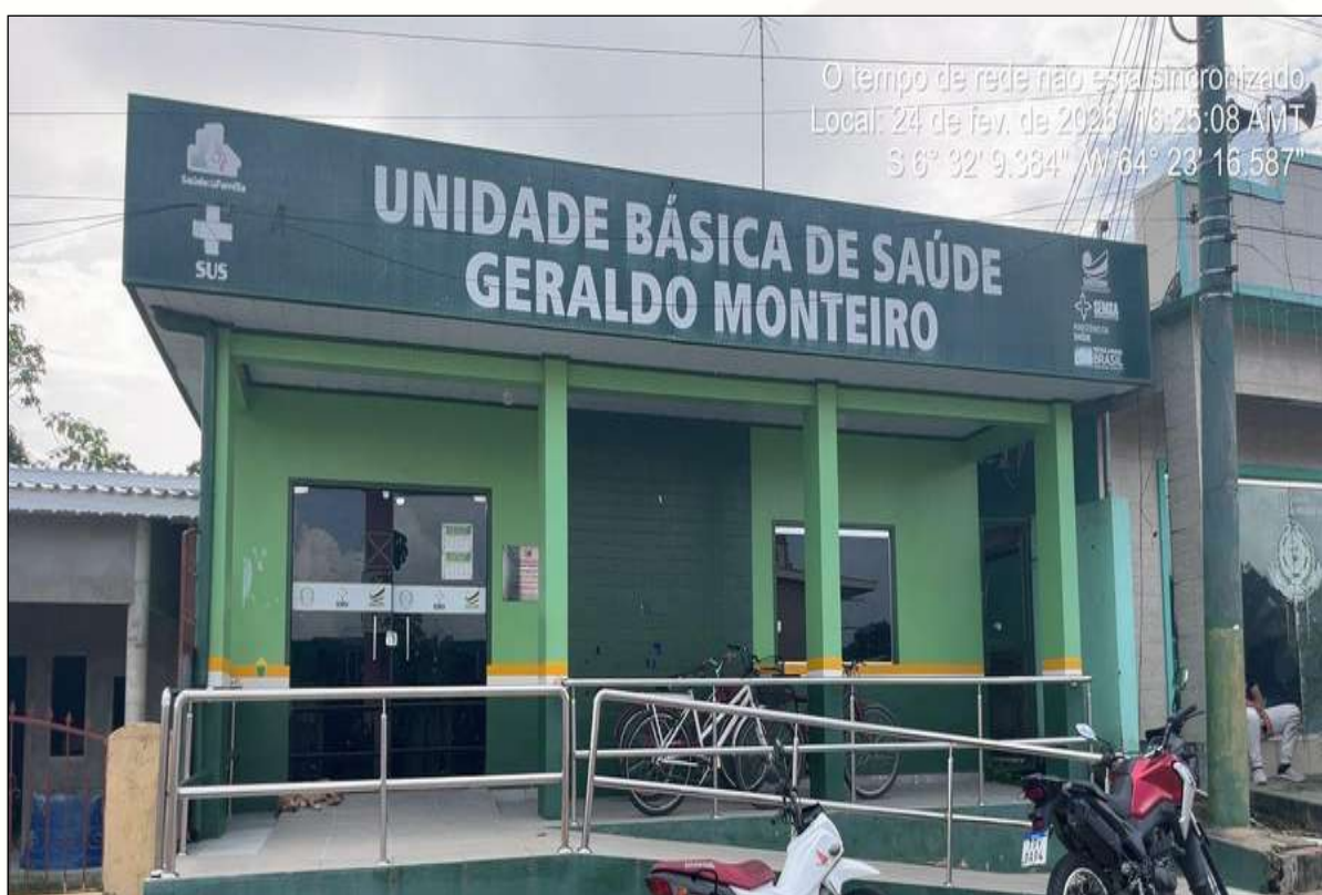
Figura 59 - UBS de Canutama/AM (em reforma). Fonte: Registro de campo (2026).
