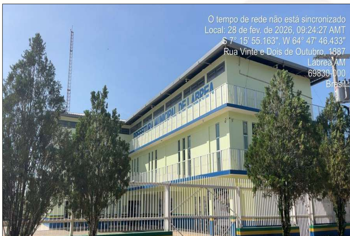
Figura 67 - Prefeitura Municipal de Lábrea/AM. Fonte: Registro de campo (2026).
