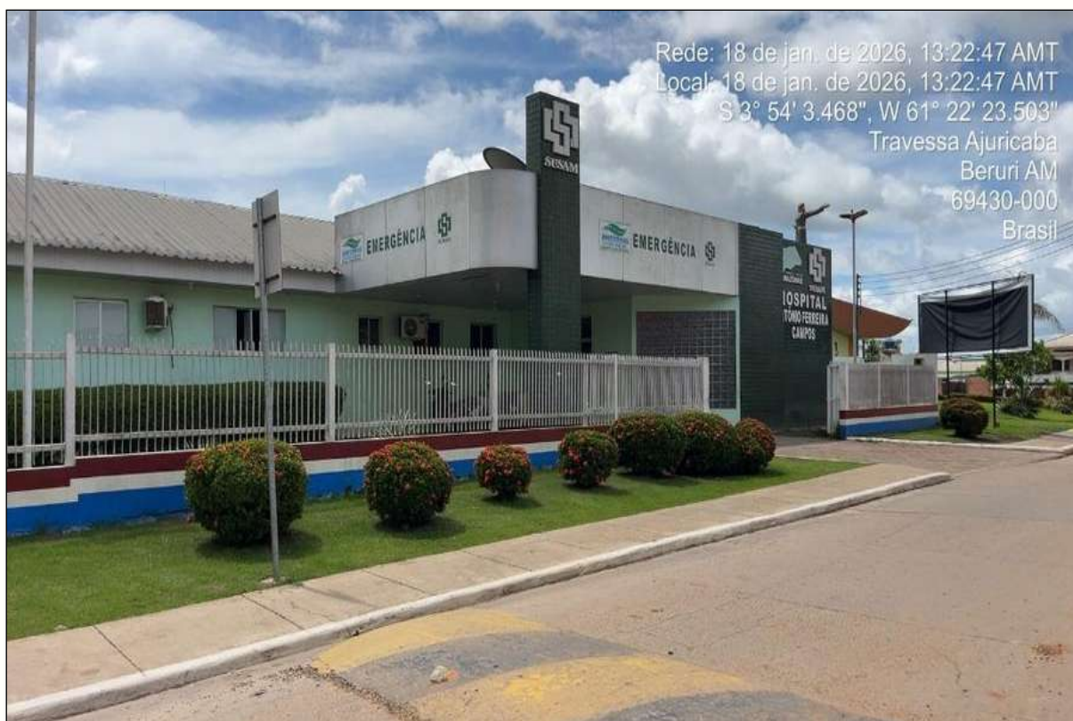
Figura 18 - Hospital Municipal em Beruri/AM. Fonte: Registro de campo (2026).
