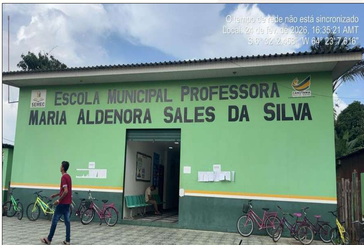
Figura 61 - Escola municipal de Canutama/AM. Fonte: Registro de campo (2026).
