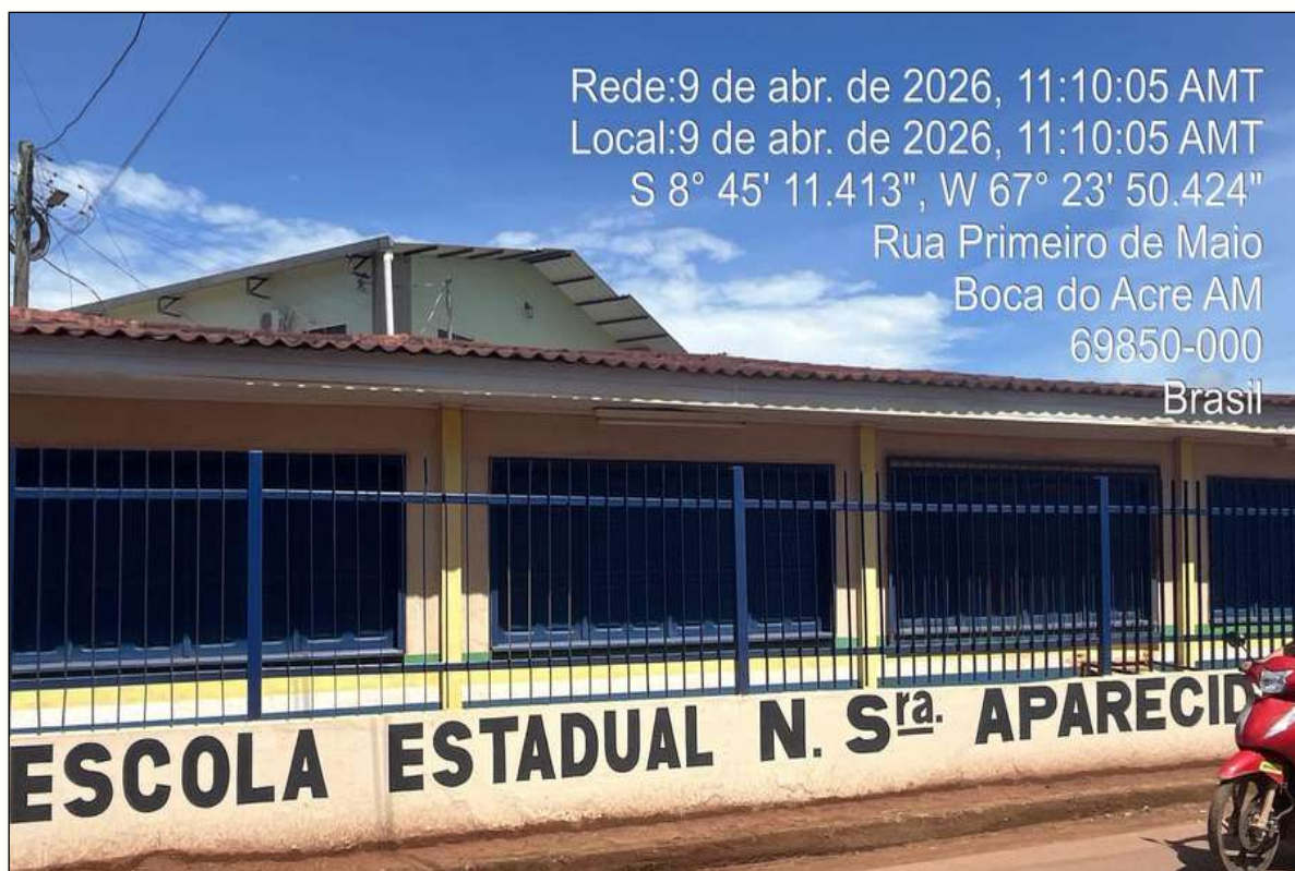
Figura 110 - Escola estadual de Boca do Acre/AM. Fonte: Registro de campo (2026).
